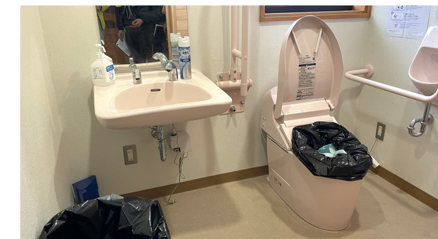
使えなくなった水洗トイレに携帯トイレをセットした状態 A plastic bag from the toilet kit is placed on a disabled flush toilet.
