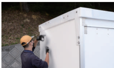
3 屋根をアイボルトで固定する
