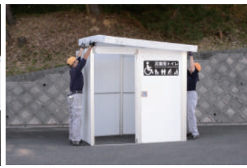
2 補強アルミ・屋根を取付ける
