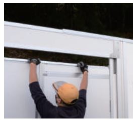
2 補強アルミ・屋根を取付ける
