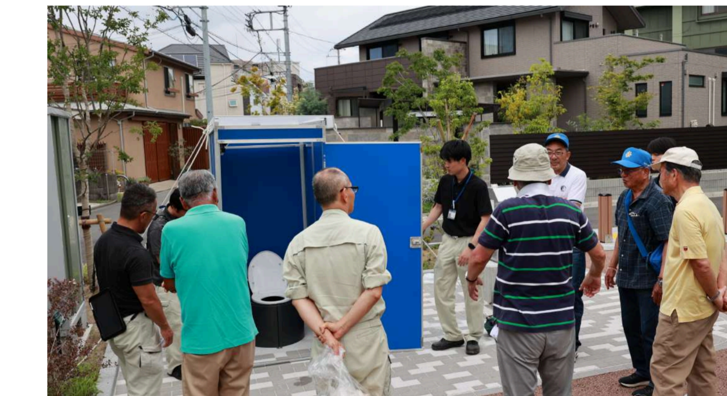
マンホールトイレ (非常時にトイレとして使用) Utility hole toilet (Can be used as a toilet in emergencies)
