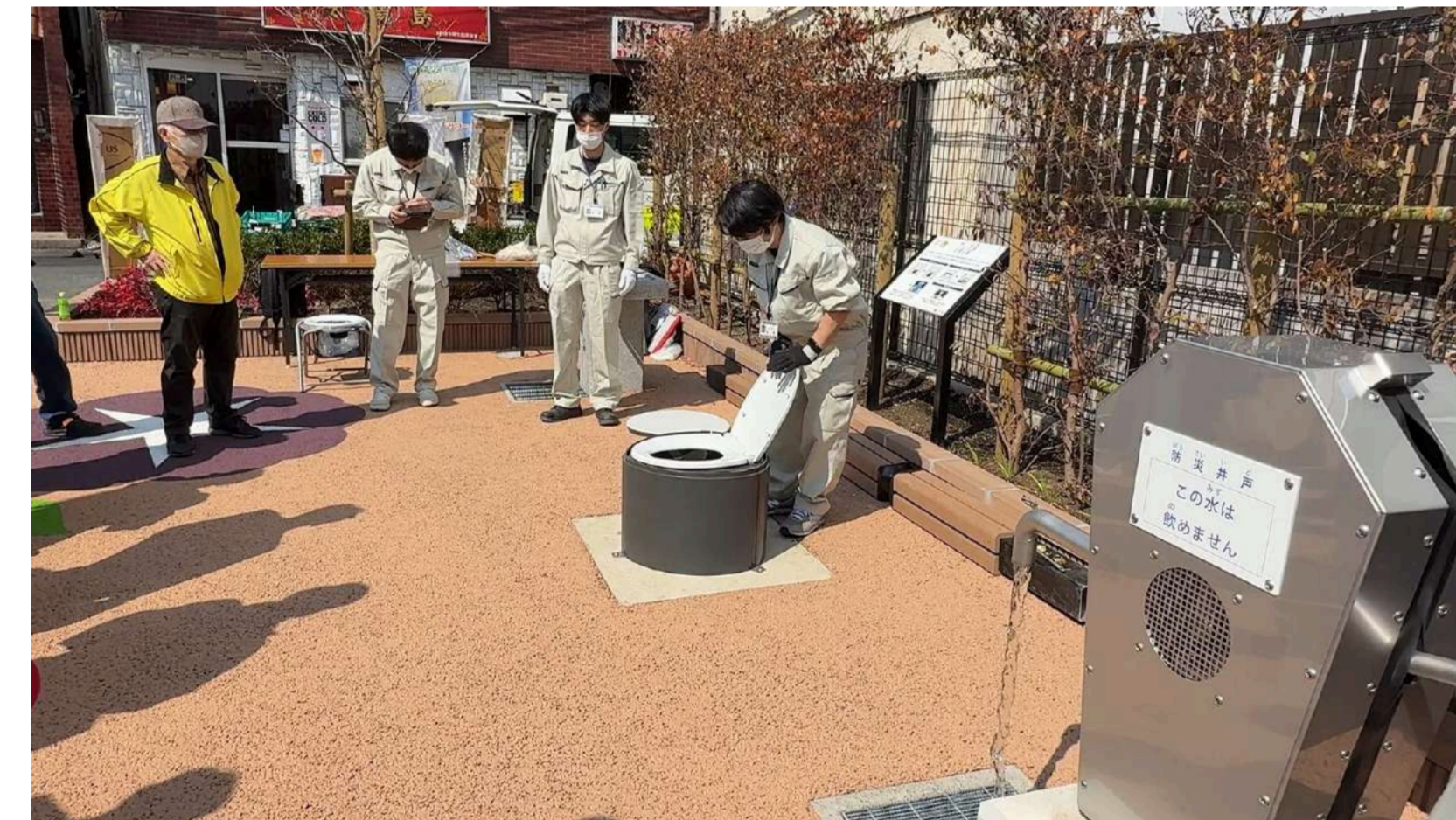
江戸川区に設置されているスツールタイプのマンホールトイレと防災井戸
