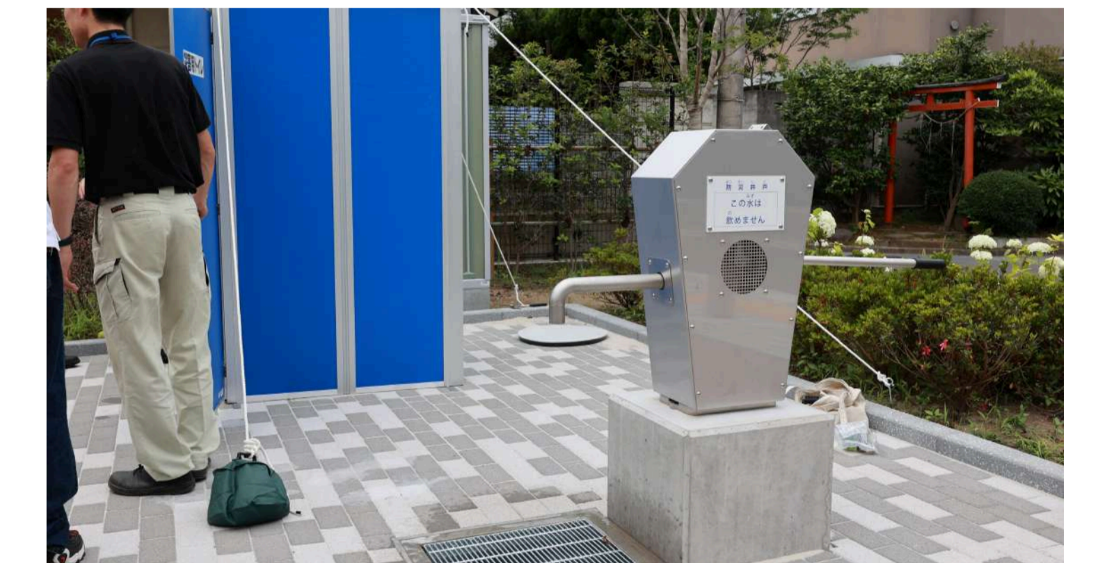
防災井戸 (非常時にマンホールトイレ用の水として使用) Disaster preparedness well (Can be used as water for utility hole toilets in emergencies)
