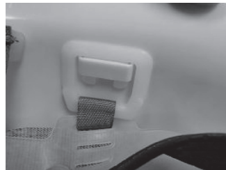
①内装取付部の様子
